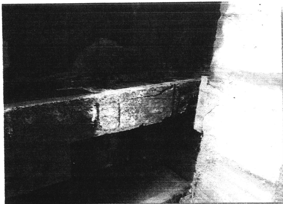
5.1. Повреди по главни греди при устой, страна кв. „Ралица“ – отвор №10.
